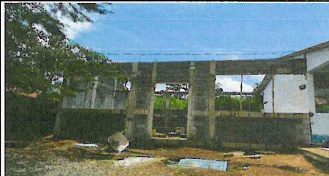
Foto 2: Implementación de estructura de soporte de metal para el aula.
