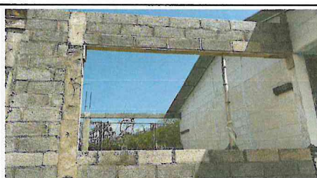
Foto 4: Implementación de ventanas con perfiles de metal en aula.
