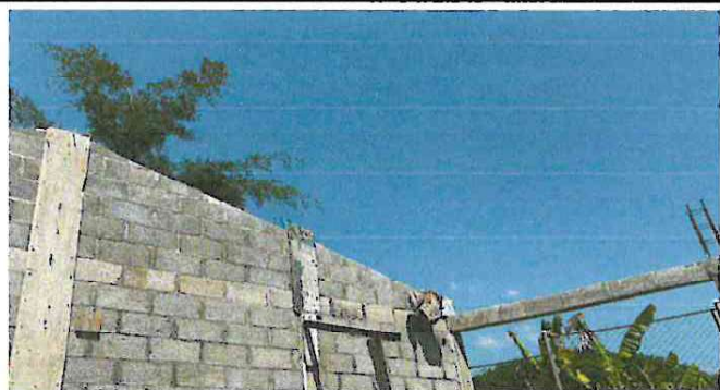
Foto 1: Sustrucción de lámina (acanalada o duralita) por lamina troquelada en aula.
